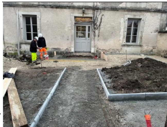
Construction de la rampe d'accessibilité →
