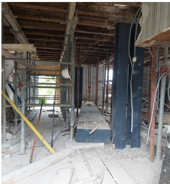
Pose de la poutre IPN
